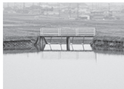
写真2 洪水吐 (志方町西牧地区の犬立池)
