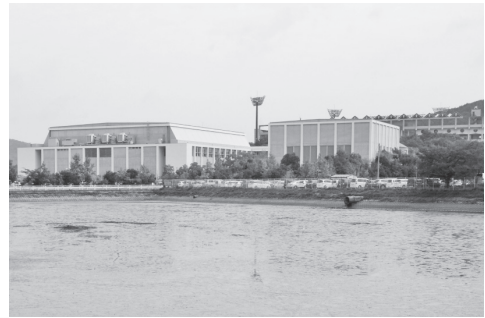
写真 3 加古川市立総合体育館 2013 年 11 月 4 日矢嶋巖撮影
